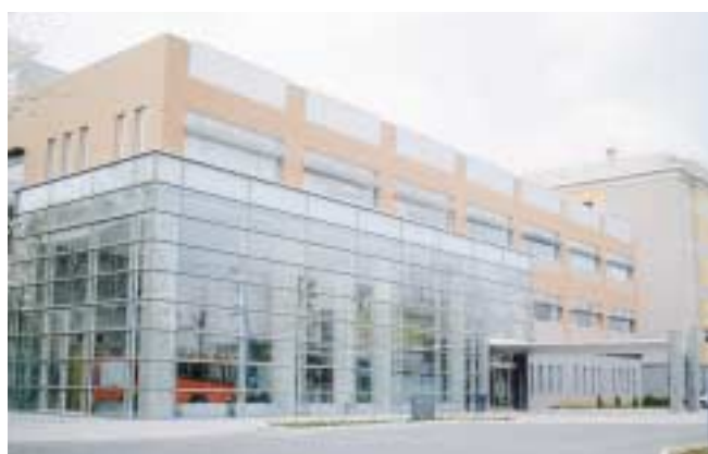
消防研究所本館外観
